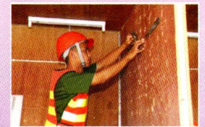
1.4 งานไฟฟ้าเบื้องต้น
