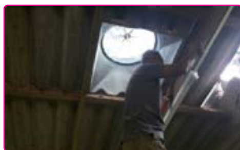
ติดตั้งลูกหมุนระบายอากาศโรงทอผ้า วัดพระพุทธร บ้านปลักช้าง และบ้านตอหลัง
